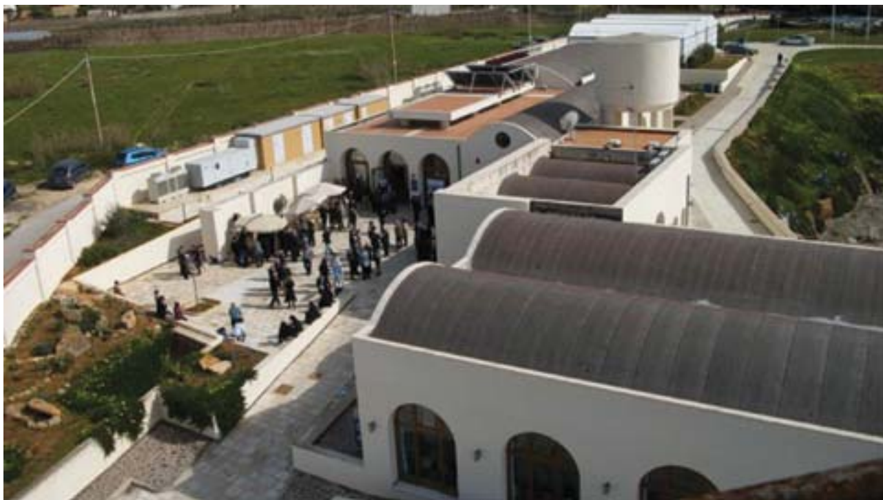
Capo Granitola, la tonnara ristrutturata
